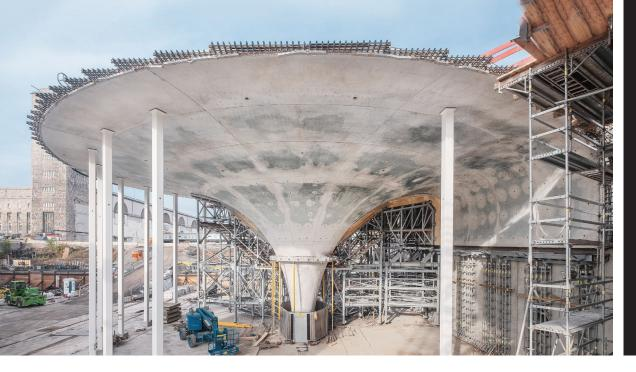
Betonierte Kelchstütze für die Bahnsteighalle des neuen Stuttgarter Tiefbahnhofs. © Ed. Züblin AG / Achim Birnbaum
